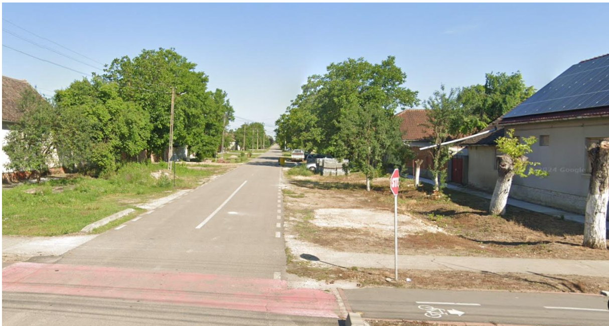
Figura 21 Stradă recent modernizată - strada Micșunelelor, Sântana
